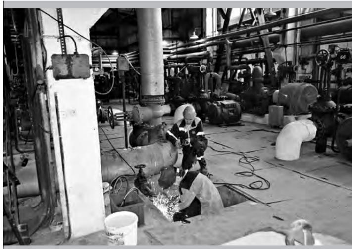
**Е.З. Котельников, электрогазосварщик, и А.Ф. Южанинов, слесарь по ремонту оборудования котельных и пылеприготовительных цехов, производят замену участка трубы на дренаже. Ремонт второго водогрейного котла**
