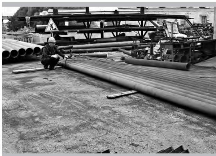
**И.К. Паршаков, слесарь по ремонту оборудования тепловых сетей, красит трубы, которые будут установлены на участке теплотрассы возле литейного отделения цеха № 20**
